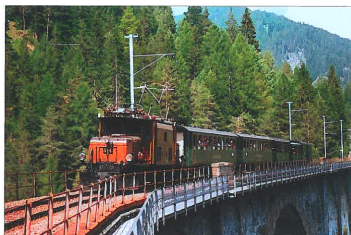
RhB-Bahnhof in Filisur: »Rhätisches Krokodil« Ge 6/6 I 414 mit Nostalgie-Extrazug auf dem Wiesener Viadukt. Foto: Dirk Zimmermann
