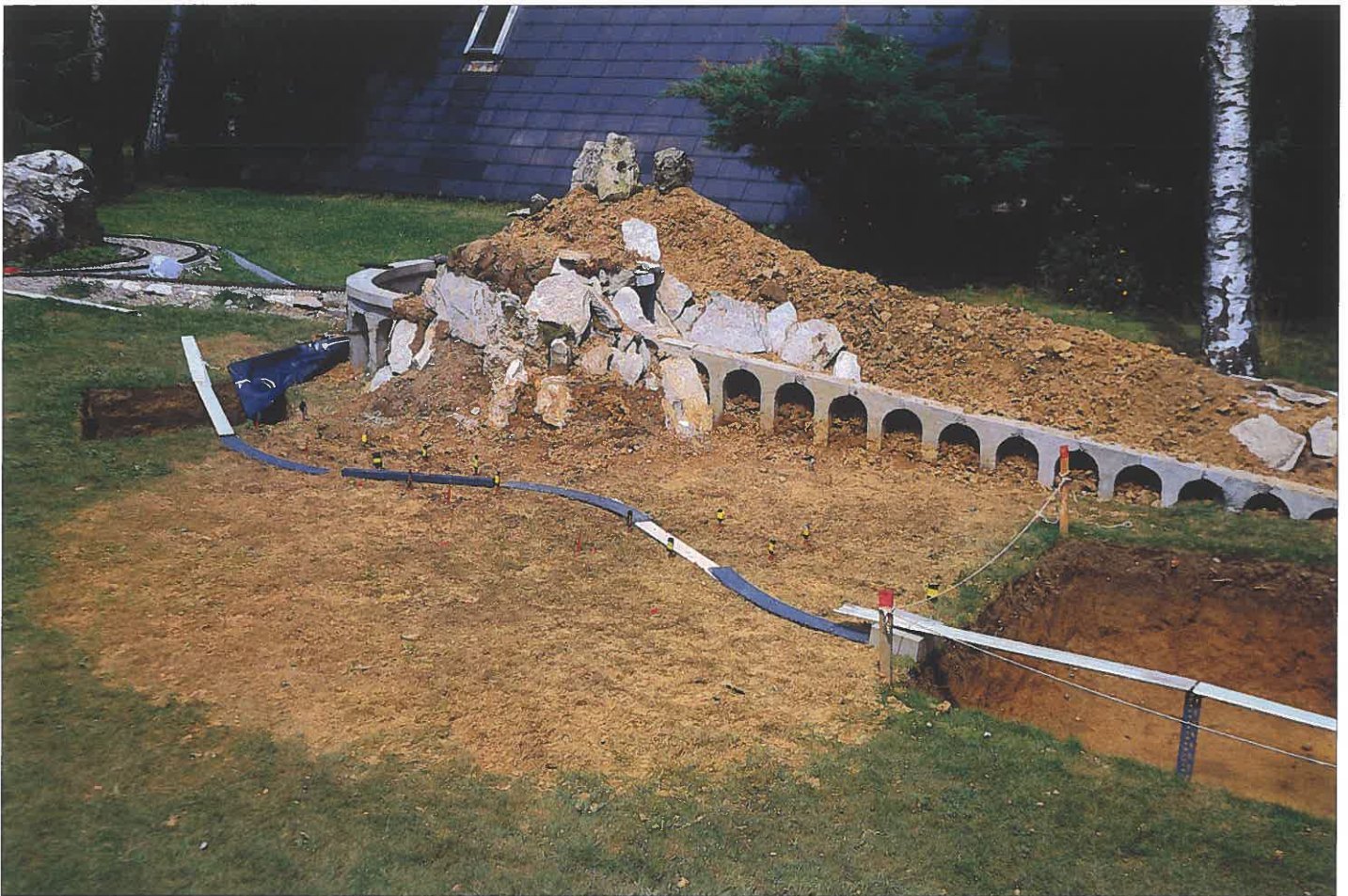
Neben den Rohbaualpen sind die Gruben für die beiden Seen ausgehoben. Man beachte den perfekt nach Art der Tiefbauingenieure abgesteckten späteren Flußlauf.
