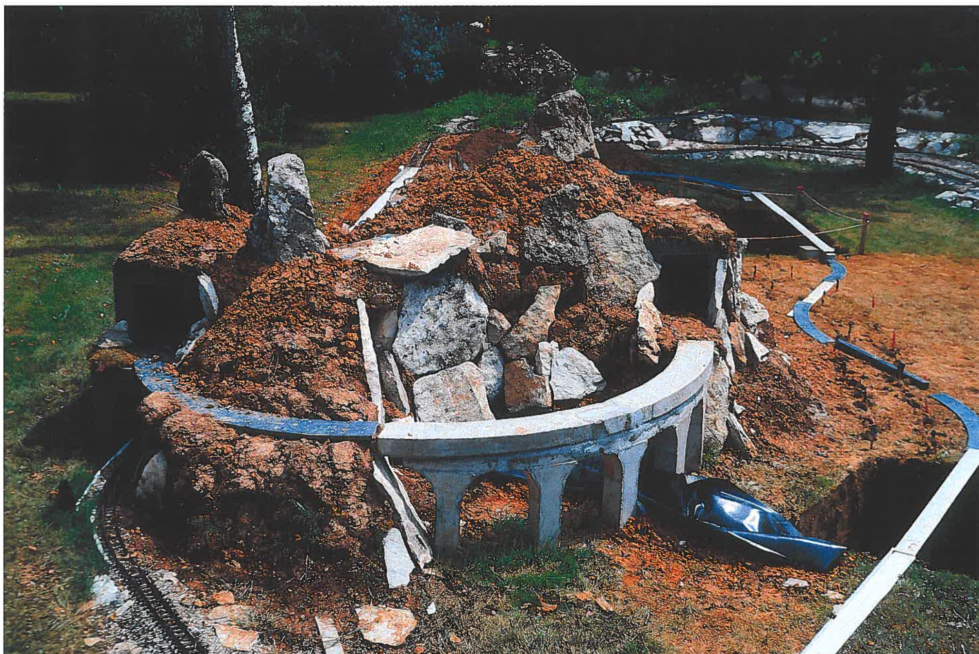
Die Alpen wurden erbaut, und schon sind die Bruchsteine mit Erde aufgefüllt und verdecken den Tank des Wasserfalls, dessen Wasser sich rechts in das tiefe Loch ergießen werden.
